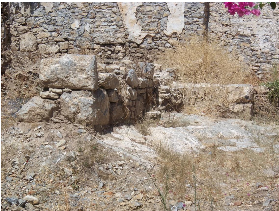
Εικόνα 69. Παλαιό κτίσμα με χρήση αρχαίων λίθων στην πάνω αυλή του Σπετσιώτη (Σκουλιούφα).
