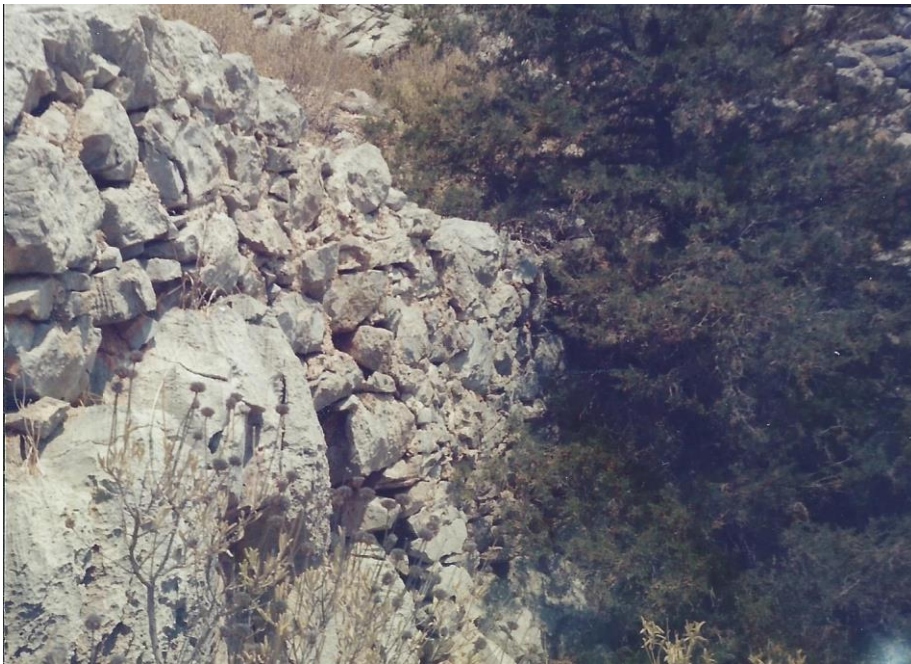
Εικόνα 133. Τμήμα τείχους κάστρου Δοκού. Μοιάζει να είναι ξερολιθικό, ή έχει ξεπλυθεί το σαθρό συνδετικό υλικό του. Εκμεταλλεύεται τον φυσικό βραχισμό και την κλίση του εδάφους και καταφέρνει να δημιουργεί μια εξωτερική πρόσοψη αρκετού ύψους.
