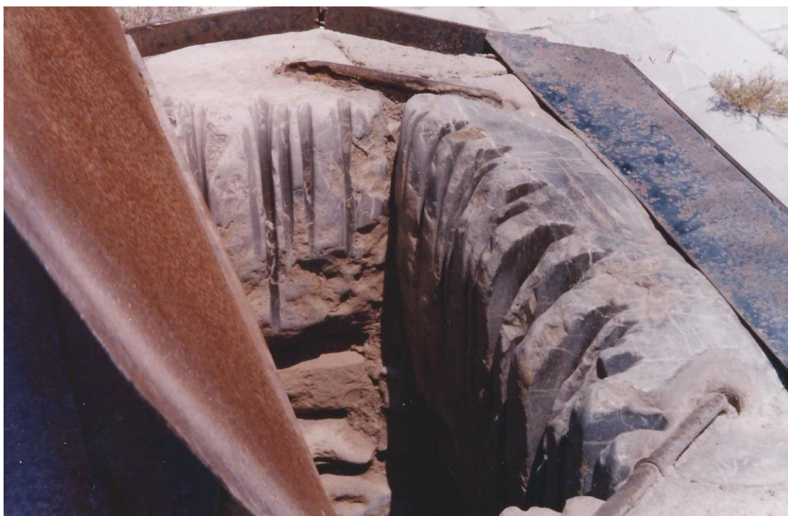
Εικόνα 141. Το στόμιο του πηγαδιού της Μιλίντρας. Είναι πανωσήκωμα, αφού πιο κάτω έχει άλλο παλαιότερο στόμιο με μικρότερες αυλακωμένες πέτρες.
