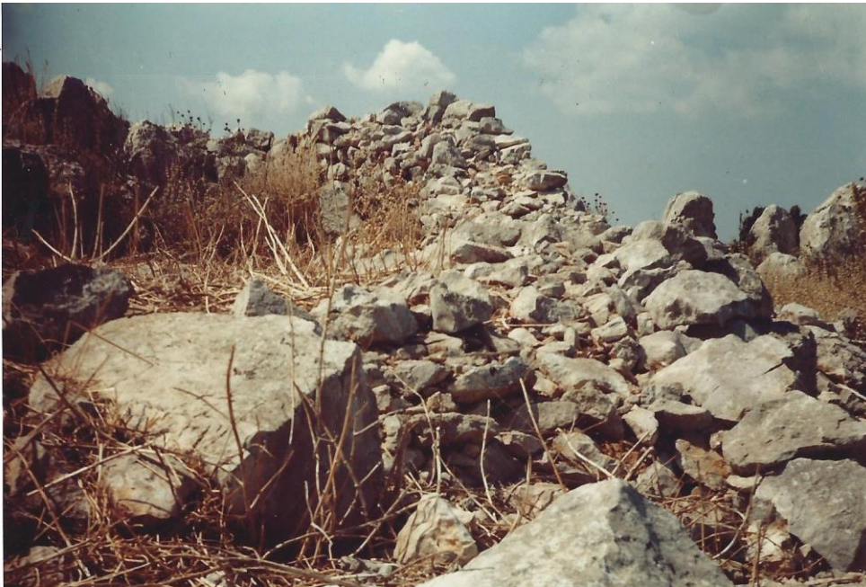
Εικόνα 137. Τμήμα τείχους. Οι πέτρες όλες είναι ακατέργαστες και μάλλον χωρίς συνδετικό υλικό.
