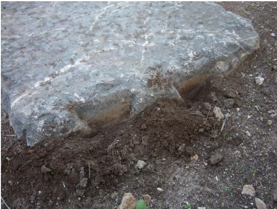
Εικόνα 45 β : Δύο φωλιές που απέμειναν σε ογκόλιθο της ευθυντηρίας του ναού.
