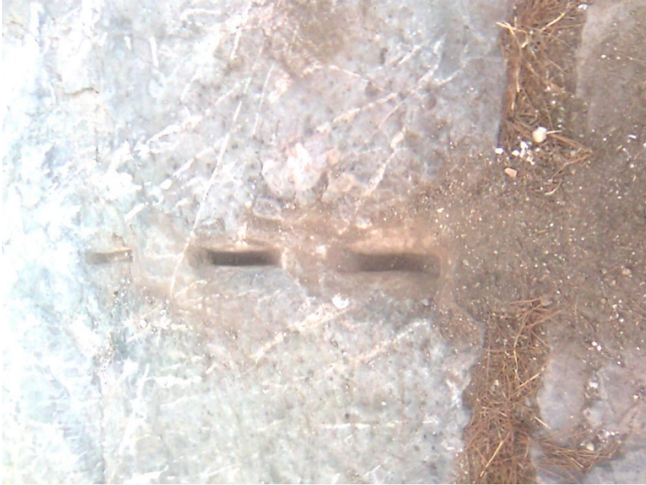
Εικόνα 44: Κάθετες ρηχές φωλιές σε έσω μπλόκια της ευθυντηρίας, ευθυγραμμισμένες χωρίς χάραξη αυλακιού.
