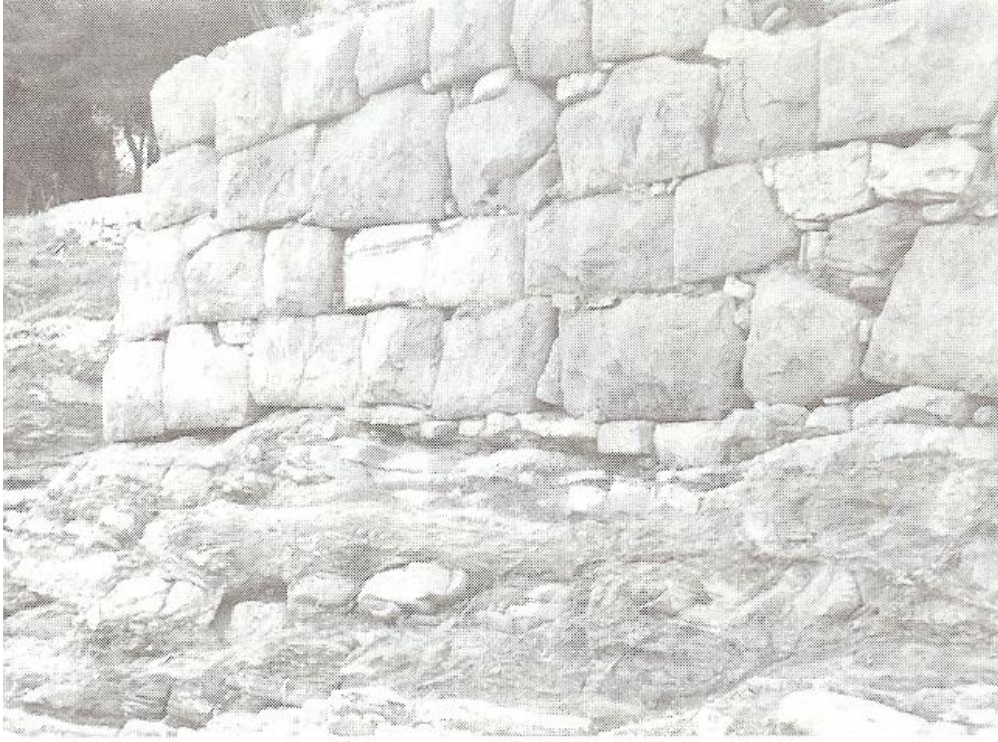
Εικόνα δ: Βόρειο τείχος. Ο θεμέλιος βραχισμός έχει λαξευτεί, ώστε να προσθέτει ύψος στο τείχος.
