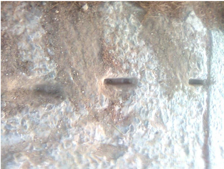
Εικόνα 45: Κάθετες ρηχές φωλιές σε έσω μπλόκια της ευθυντηρίας, ευθυγραμμισμένες χωρίς χάραξη αυλακιού, παρόμοιες με της εικόνας 44.
