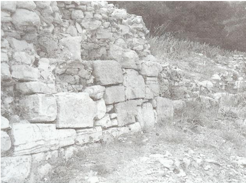
Εικόνα ε: Βόρειο τείχος. Το τμήμα αυτό έχει επισκευαστεί κάποια παλιά εποχή. Φαίνονται οι θέσεις απ' όπου έχουν αφαιρεθεί μπλόκια για πούλημα.
