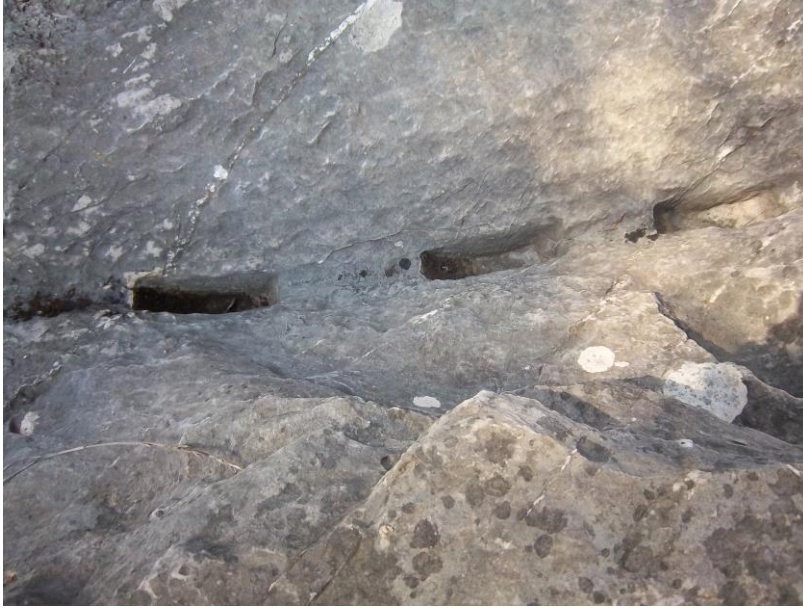
Εικόνα 92α: Λεπτομέρεια της εικόνας 92, όπου φαίνεται καθαρά το σχήμα της φωλιάς και ο τρόπος λάξευσης του αυλακιού που τις φέρει.
