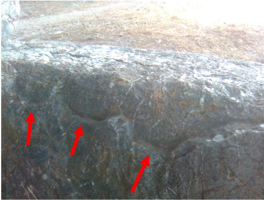
Εικόνα 16: Σε συμπαγές ασβεστολιθικό μπλόκι καλής ποιότητας 3 φωλιές σχεδόν στην ίδια ευθεία. Βρίσκεται ενσωματωμένο στη δυτική πλευρά του πύργου.
