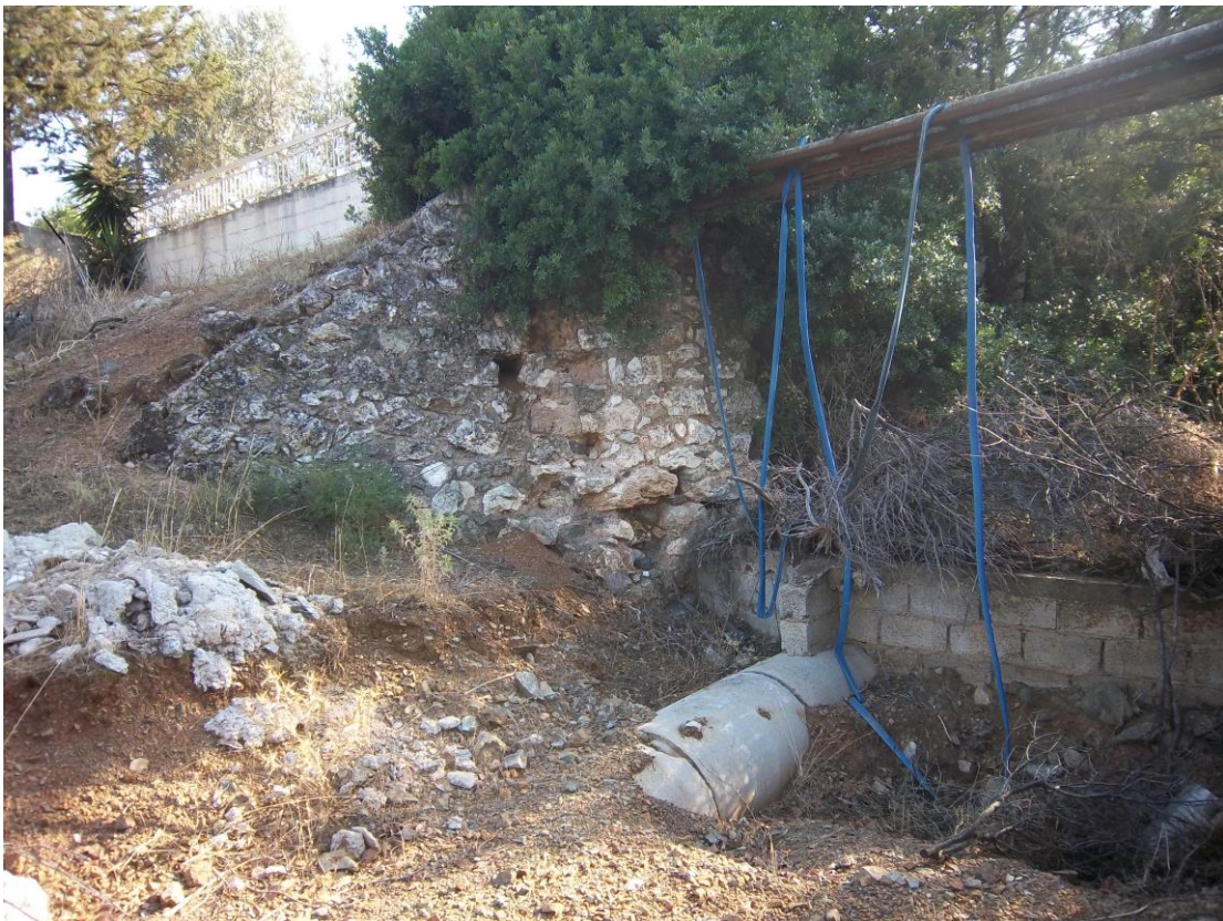
Εικόνα 73. Από το καλοκτισμένο γεφυράκι περνούσε το τραινάκι του λευκόλιθου πάνω σε στενές ράγες. Αργότερα πέρασαν από κει μεταλλικούς αγωγούς οι περιβολαράιοι της περιοχής για να ποτίζουν τα περιβόλια τους που σήμερα όλα έχουν ξεραθεί. Λίγο δεξιά του γεφυριού σώζονται και αγωγοί μικροί τσιμεντένιοι που έβγαιναν σε καλούπι σαν τα τσιμεντολίθια και η ένωσή τους γινόταν με καλό σοβάντισμα.
