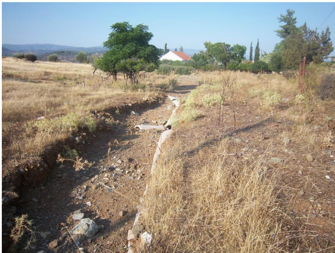
Εικόνα 74. Ο τσιμεντένιος αγωγός έφραξε και το ρέμα επανήλθε στη θέση του.
