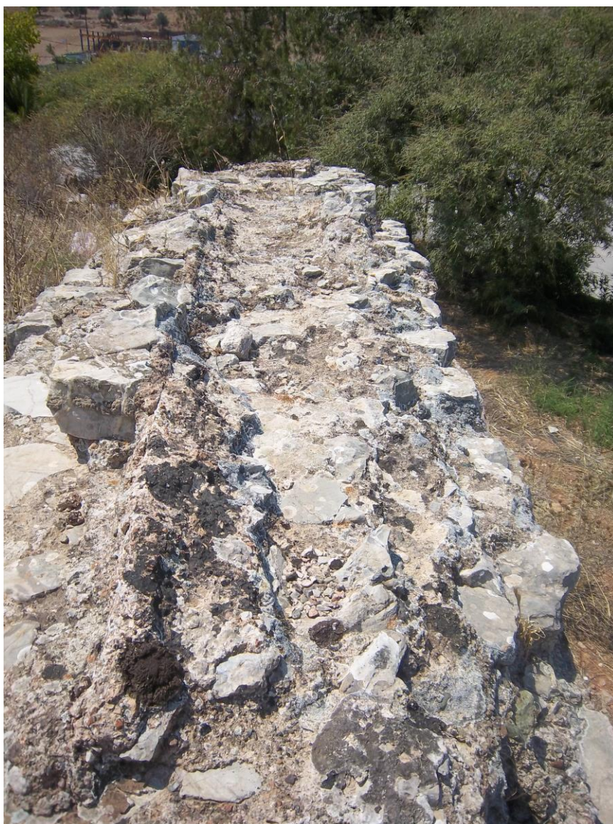
Εικόνα 49. Στο πάνω μέρος φαίνεται η βάση του αύλακα, όχι στο κέντρο, αλλά μετατοπισμένη προς την κατάντη μεριά.
