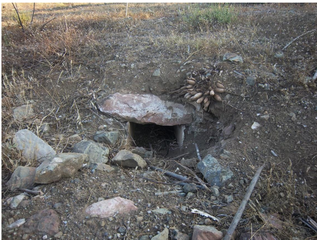
Εικόνα 90. Αν και το τείχος όπου εδράζεται ο αύλακας είναι στενό και όχι σαν του ρωμαϊκού υδραγωγείου, η κάλυψη του αύλακα γίνεται με πολύ μεγάλες και παχιές πλάκες.
