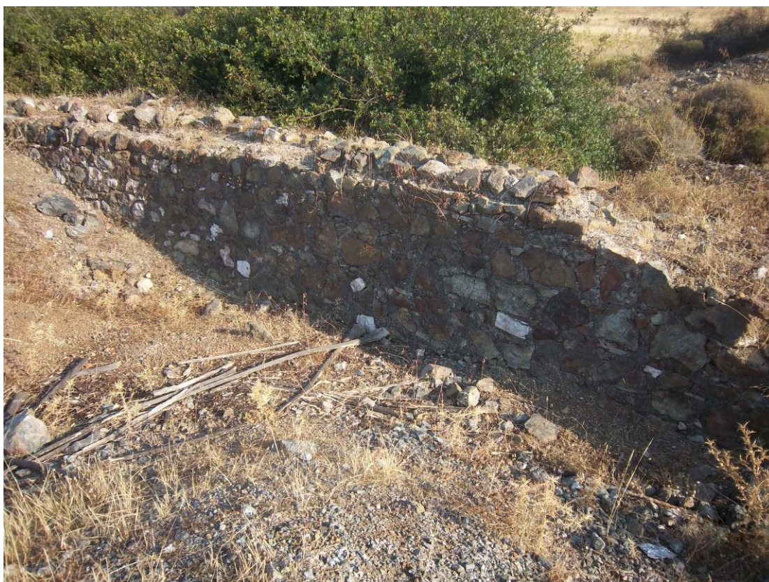
Εικόνα 76. Το καλοκτισμένο τοιχίο (δέση) που εκτρέπει το ρέμα προς τη μάντρα του Ζωγράφου. Θέση 1 στην Εικόνα 75.
