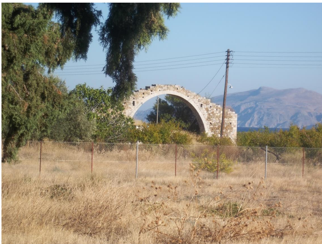
Εικόνα 109. Η μεγαλοπρεπής και καλοκτισμένη «καμάρα» στο Πλέπι. Καλοκτισμένη και στις γωνίες της. Είναι συμμετρική. Ανεβαίνεις στο υψηλότερο σημείο με σκαλοπάτια. Στη τοιχοποιία της παρατηρούμε μικρές τετράγωνες οπές, όπου στηρίζονταν δοκάρια κατά την κατασκευή της. Δύο όμως παραλληλόγραμμες συμμετρικές και αρκετά μεγάλες οπές και από τις δύο πλευρές της, φαίνεται να ήσαν λειτουργικές.
